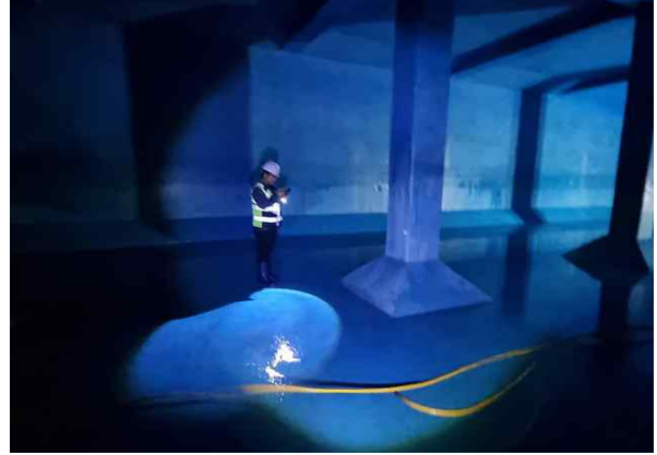
<내부 개별부재 외관조사>
