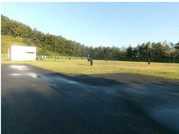
<배수지 상부 상태양호>
