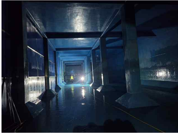
<배수지 1지 전경>
