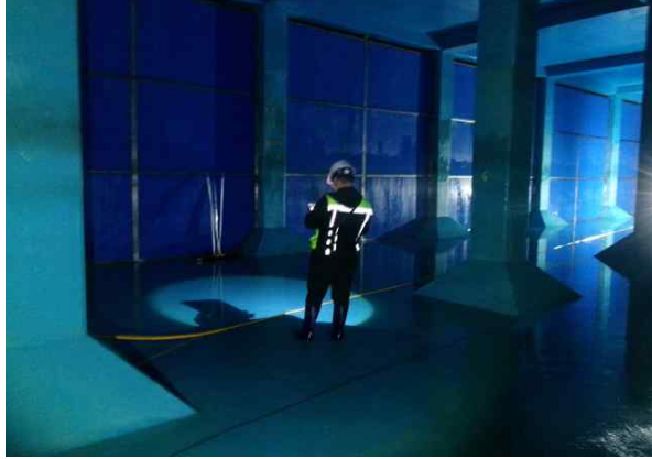
<내부 개별부재 외관조사>
